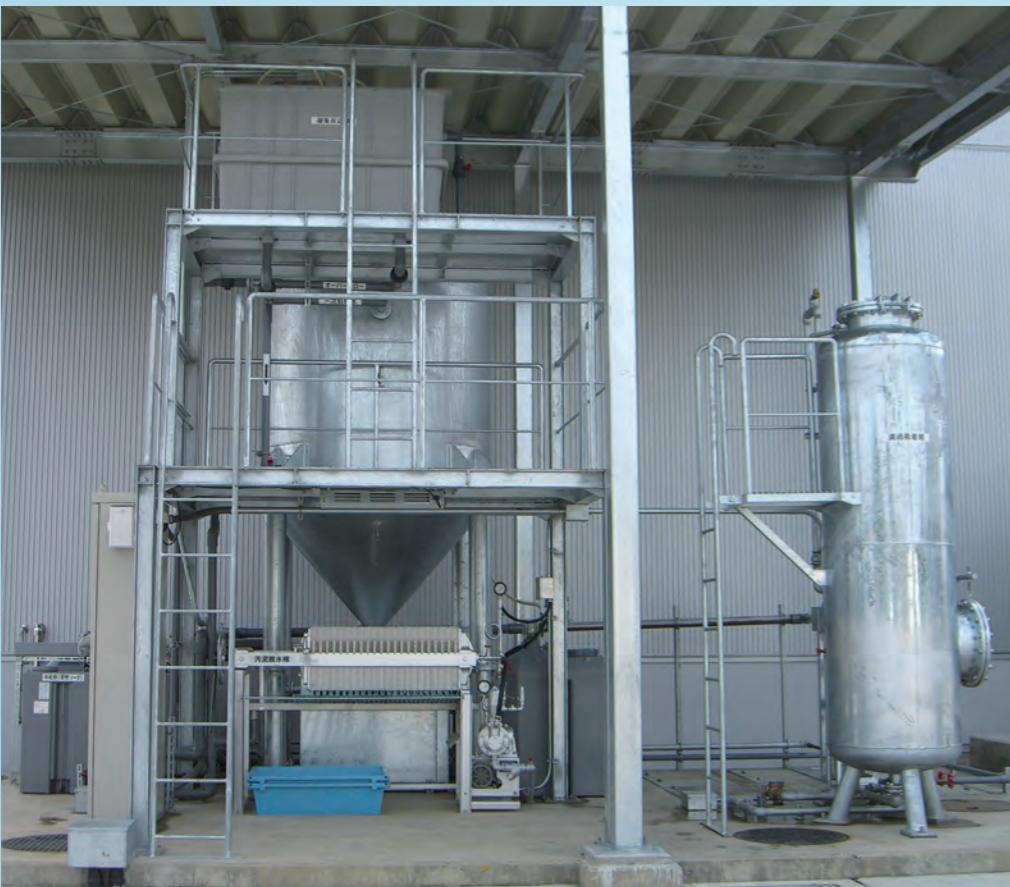
図3 バイオ処理システム活性炭1塔導入事例
