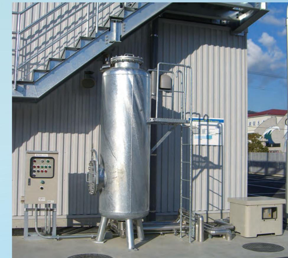
図6 油水分離槽(OSB)+活性炭1塔吸着システム導入事例
