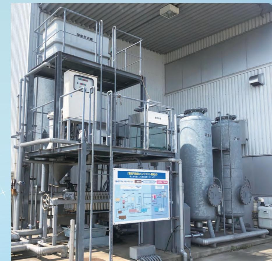
図4 バイオ処理システム活性炭 2塔導入事例
