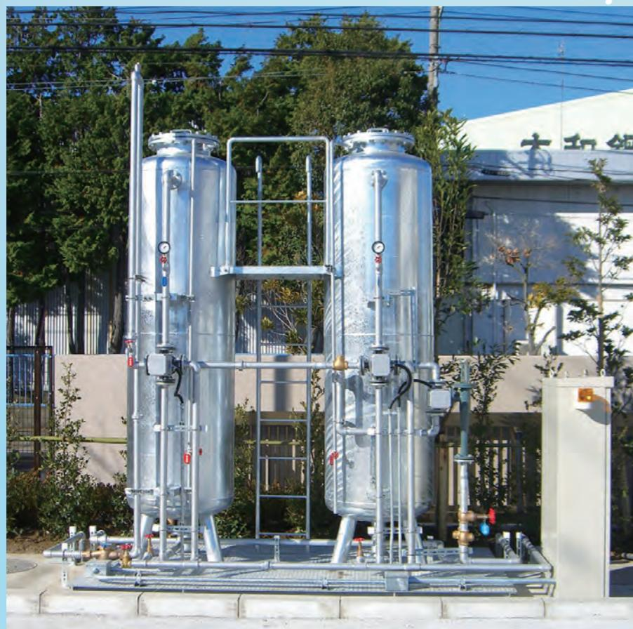
図5 油水分離槽(OSB)+活性炭2塔吸着システム導入事例
